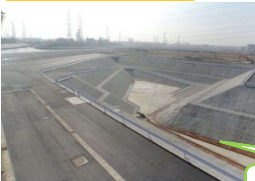
▲八幡第一雨水調整池の様子
