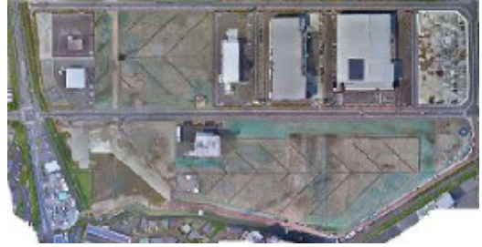
▲造成工事の様子(平成29年9月)
