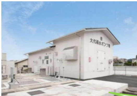
▲大代雨水ポンプ場外観の様子
