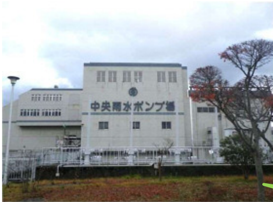
▲中央雨水ポンプ場外観の様子
