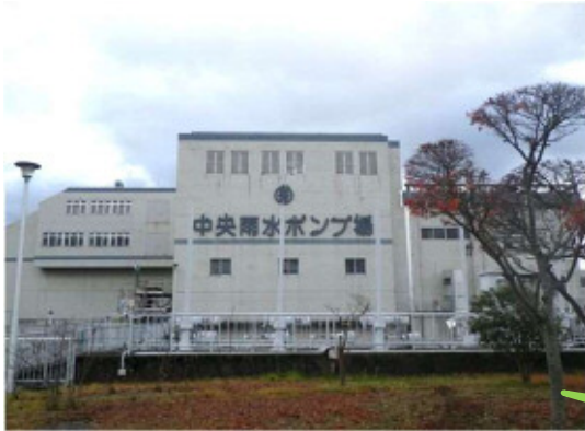
▲中央雨水ポンプ場外観の様子
