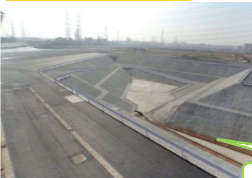
▲八幡第一雨水調整池の様子
