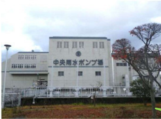
▲中央雨水ポンプ場外観の様子
