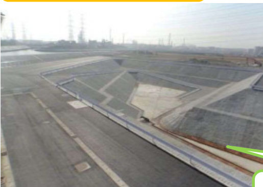
▲八幡第一雨水調整池の様子
