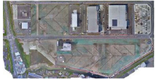
▲造成工事の様子(平成29年9月)
