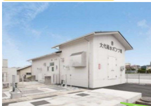
▲大代雨水ポンプ場外観の様子
