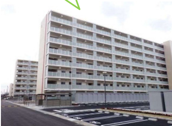
▲2・3号棟(平成28年3月)
