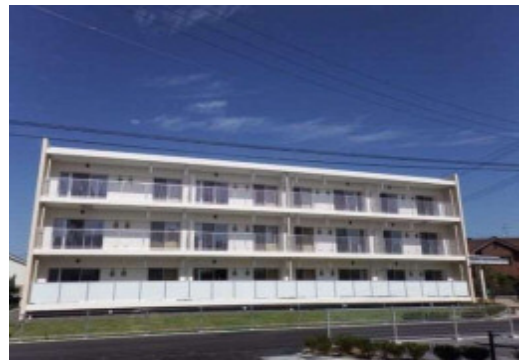
▲3号棟(平成27年9月)
