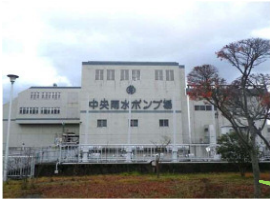
▲中央雨水ポンプ場外観の様子
