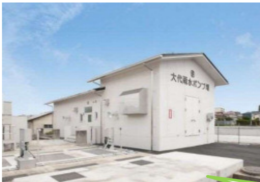
▲大代雨水ポンプ場外観の様子
