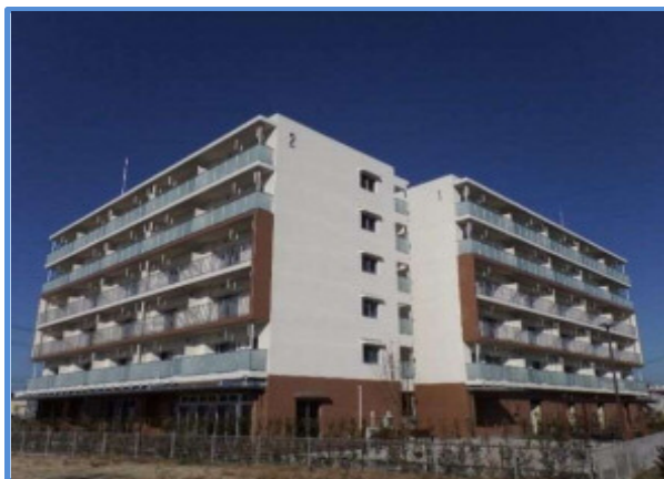
▲1・2号棟(平成28年12月)
