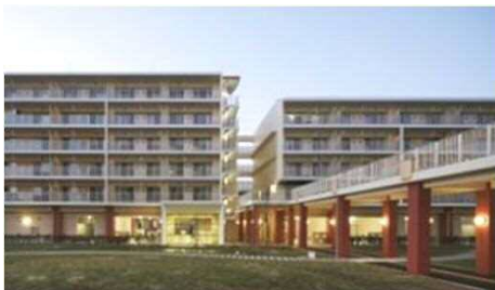
▲ 1階部分(ピロティ構造)
