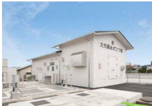
▲大代雨水ポンプ場外観の様子
