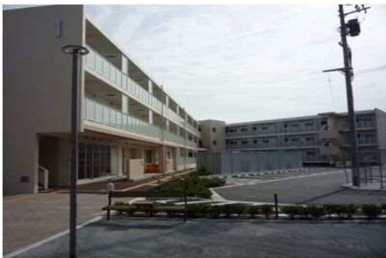
▲1・2号棟(平成27年9月)
