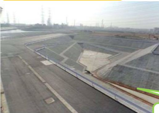
▲八幡第一雨水調整池の様子
