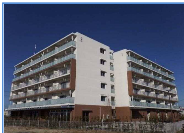
▲1・2号棟(平成28年12月)
