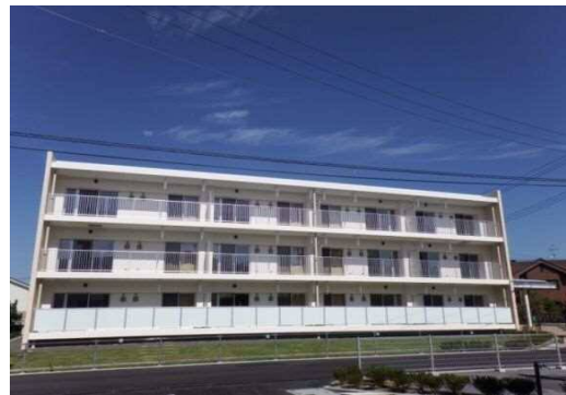
▲3号棟(平成27年9月)
