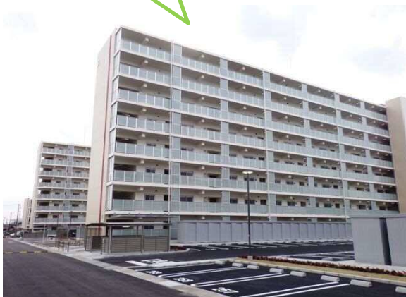
▲2・3号棟(平成28年3月)
