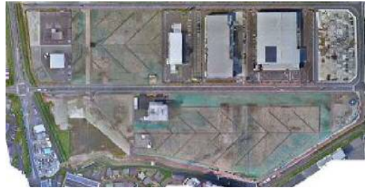
▲造成工事の様子(平成29年9月)
