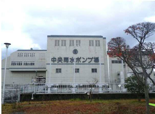
▲中央雨水ポンプ場外観の様子
