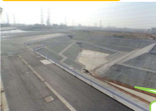
▲八幡第一雨水調整池の様子
