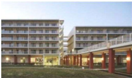
▲ 1階部分(ピロティ構造)
