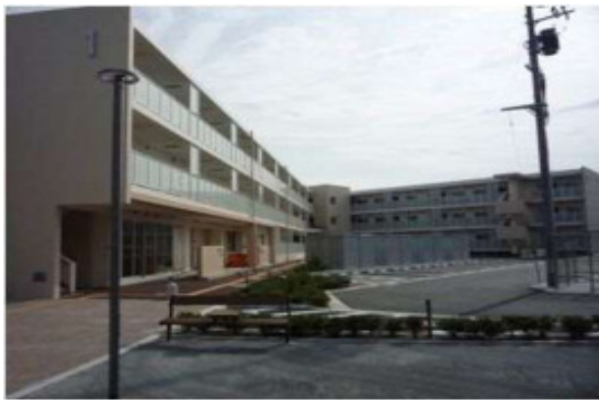
▲1・2号棟(平成27年9月)
