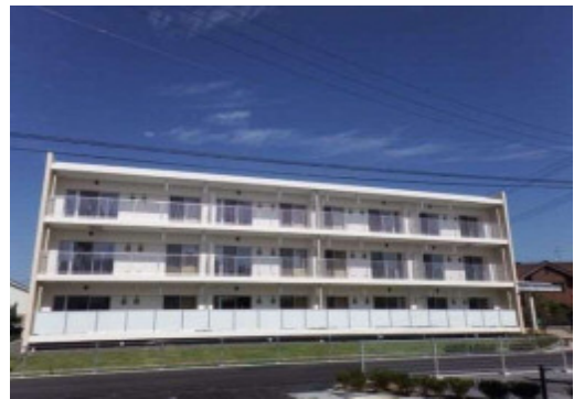
▲3号棟(平成27年9月)
