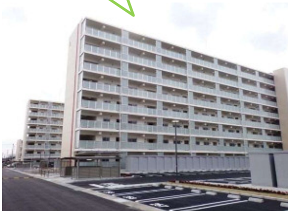
▲2・3号棟(平成28年3月)
