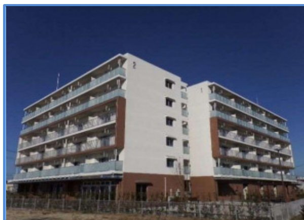
▲1・2号棟(平成28年12月)
