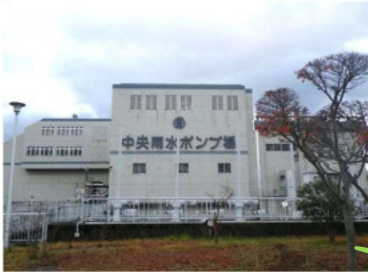
▲中央雨水ポンプ場外観の様子
