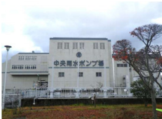
▲中央雨水ポンプ場外観の様子
