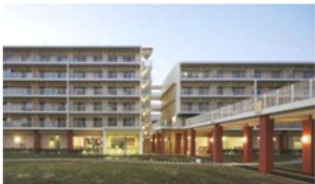
▲ 1階部分(ピロティ構造)
