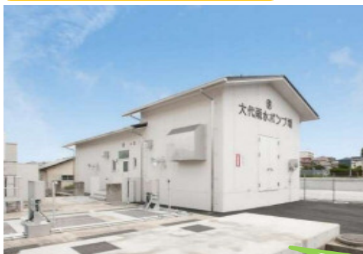
▲大代雨水ポンプ場外観の様子
