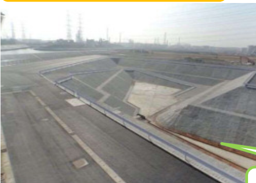
▲八幡第一雨水調整池の様子
