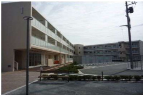
▲1・2号棟(平成27年9月)
