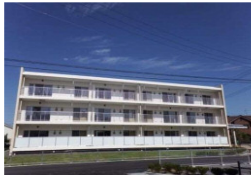
▲3号棟(平成27年9月)
