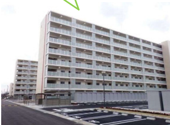
▲2・3号棟(平成28年3月)
