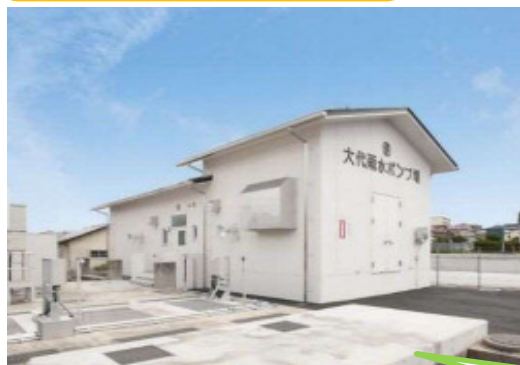
▲大代雨水ポンプ場外観の様子
