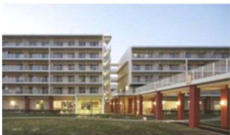
▲ 1階部分(ピロティ構造)
