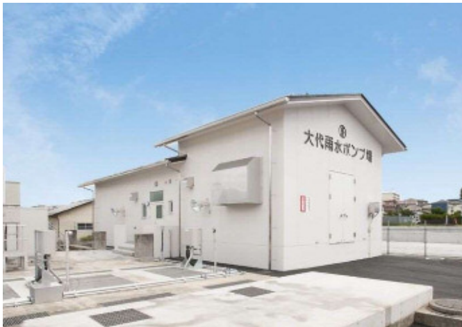
▲大代雨水ポンプ場外観の様子
