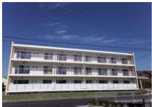
▲3号棟(平成27年9月)
