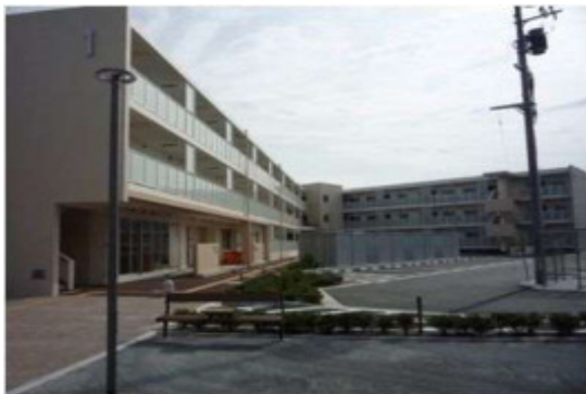
▲1・2号棟(平成27年9月)
