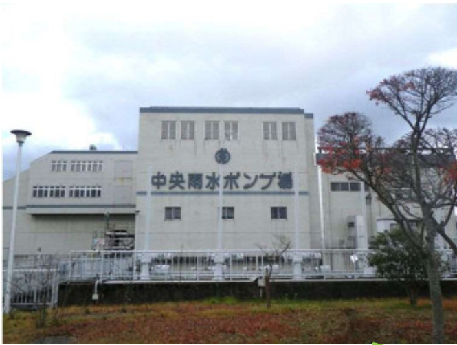
▲中央雨水ポンプ場外観の様子
