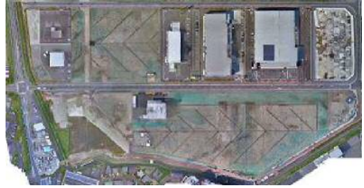
▲造成工事の様子(平成29年9月)
