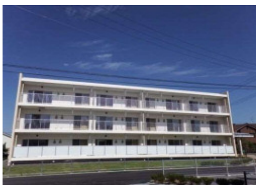
▲3号棟(平成27年9月)
