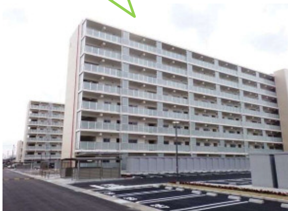
▲2・3号棟(平成28年3月)
