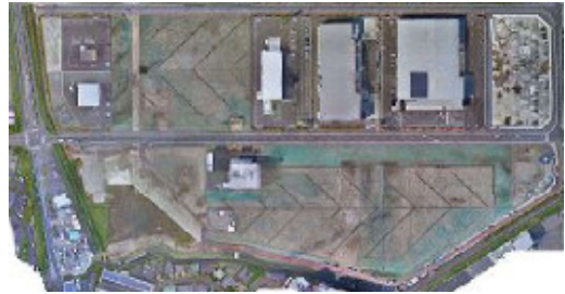
▲造成工事の様子(平成29年9月)
