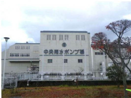
▲中央雨水ポンプ場外観の様子
