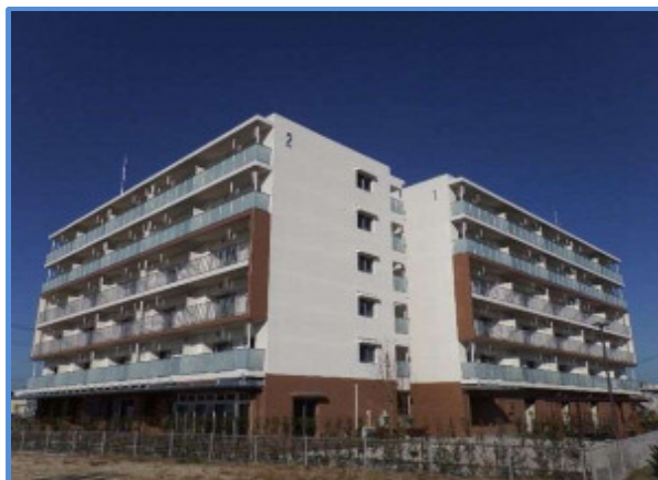
▲1・2号棟(平成28年12月)
