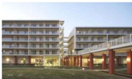
▲ １階部分（ピロティ構造）
