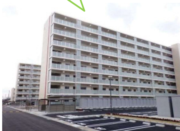
▲2・3号棟(平成28年3月)
