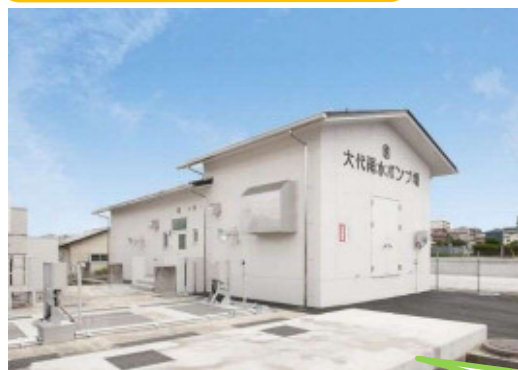
▲大代雨水ポンプ場外観の様子
