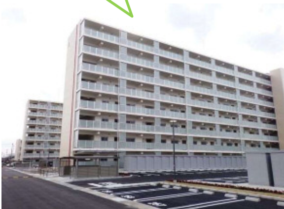
▲2・3号棟(平成28年3月)
