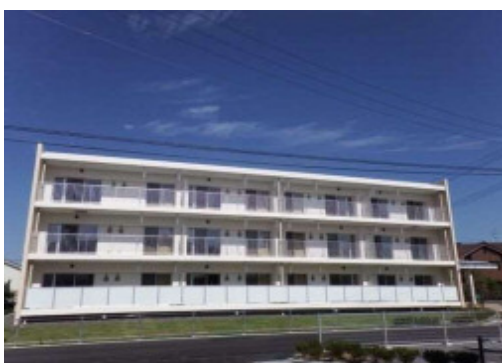
▲3号棟(平成27年9月)
