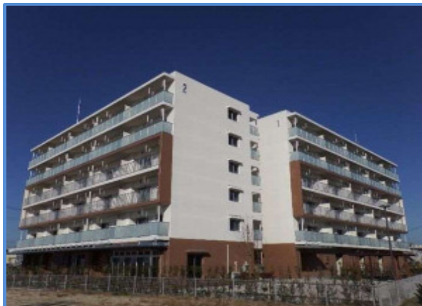
▲1・2号棟(平成28年12月)
