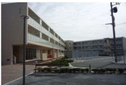
▲1・2号棟(平成27年9月)
