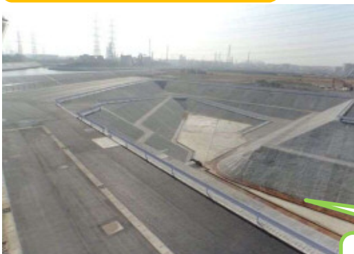
▲八幡第一雨水調整池の様子
