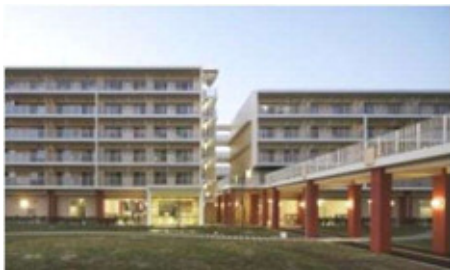
▲ 1階部分（ピロティ構造）
