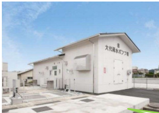
▲大代雨水ポンプ場外観の様子
