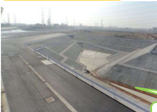
▲八幡第一雨水調整池の様子
