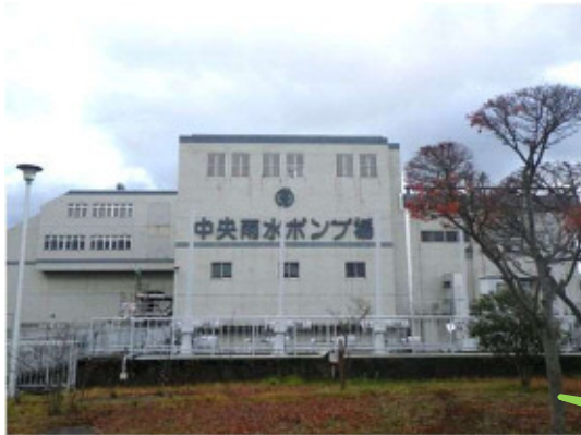
▲中央雨水ポンプ場外観の様子
