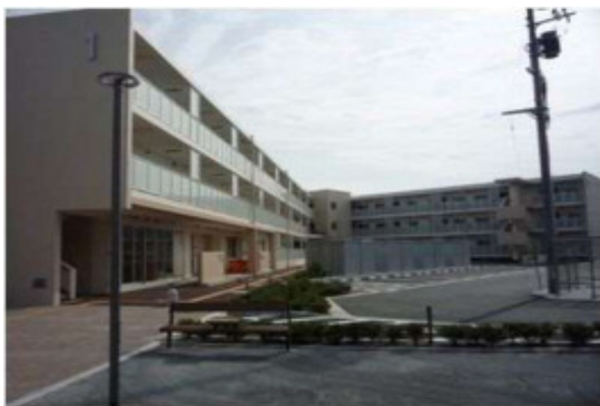
▲1・2号棟(平成27年9月)
