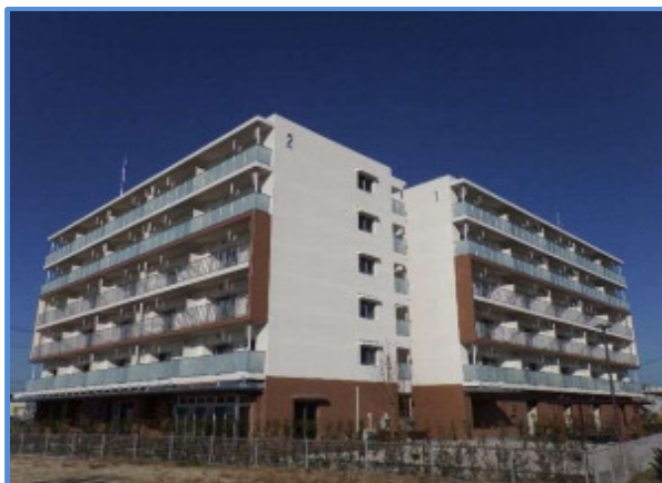
▲1・2号棟(平成28年12月)
