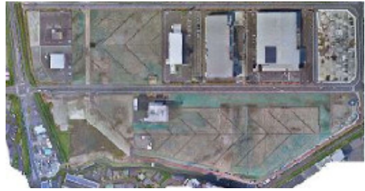
▲造成工事の様子(平成29年9月)
