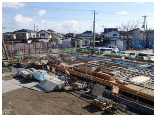
▲3号棟 基礎工事の様子(平成26年12月)
