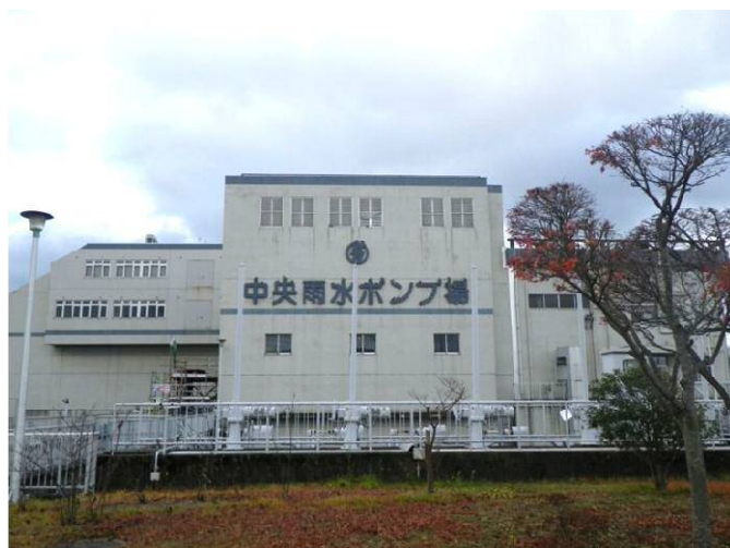
▲中央雨水ポンプ場外観の様子
