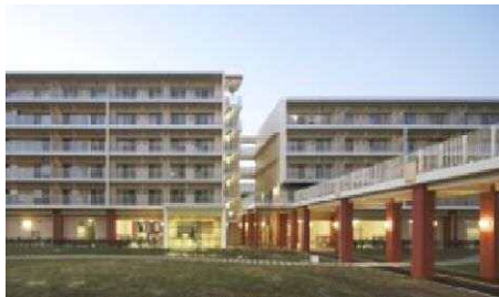
▲ 1階部分（ピロティ構造）
