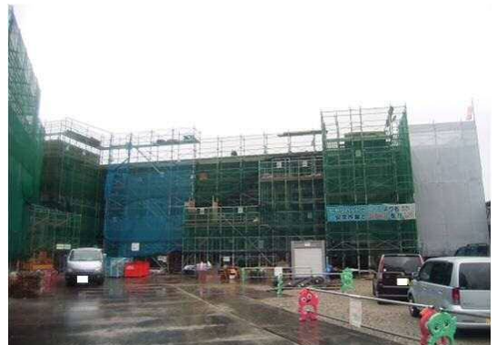
▲1、2号棟:3F躯体工事の様子(平成27年3月)
