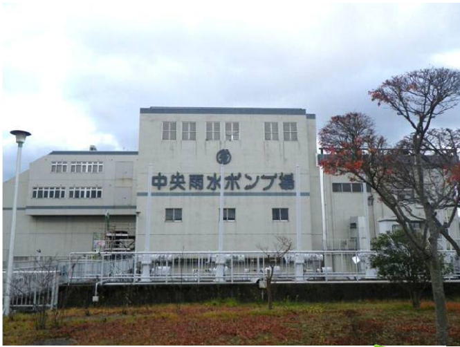
▲中央雨水ポンプ場外観の様子
