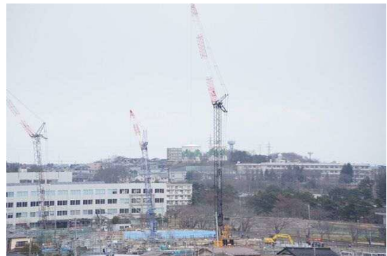
▲鶴ヶ谷地区基礎・躯体工事の様子 (平成27年3月)
