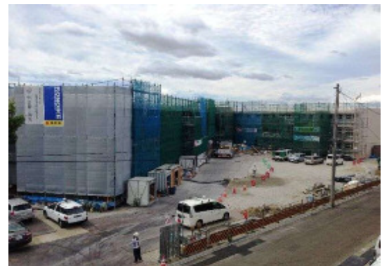
▲1,2号棟:内装工事(平成27年6月)
