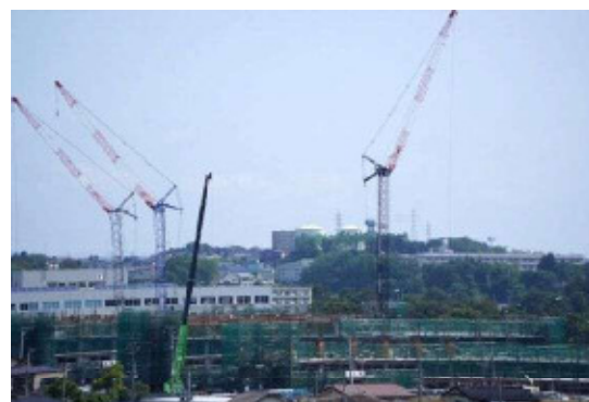
▲鶴ヶ谷地区:躯体工事の様子
