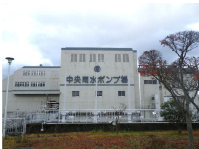
▲中央雨水ポンプ場外観の様子
