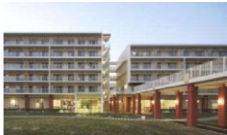
▲ 1階部分（ピロティ構造）
