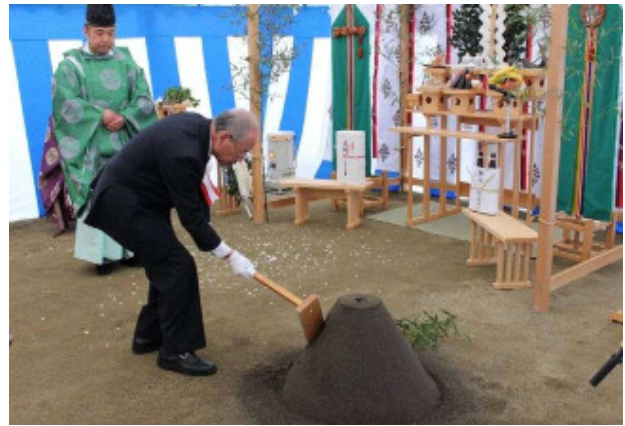
▲安全祈願祭での鍬入れの様子
