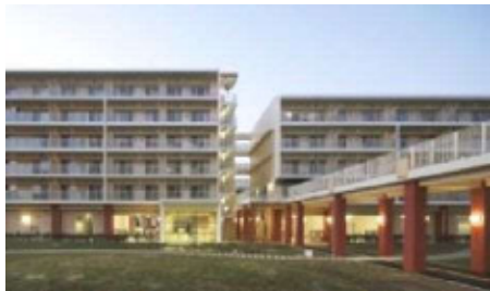
▲ 1階部分(ピロティ構造)
