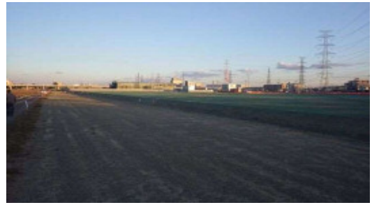
▲造成工事の様子(平成28年1月)
