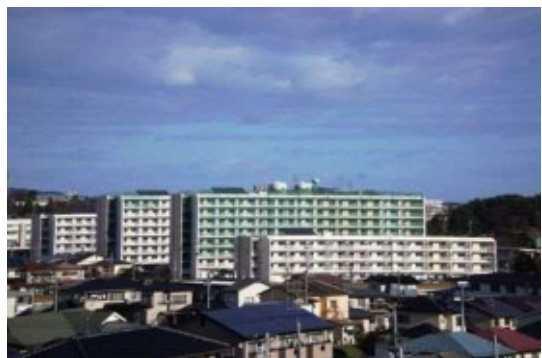
▲鶴ヶ谷地区:建築工事の様子 (平成27年11月)
