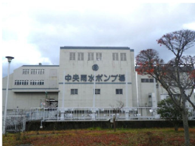
▲中央雨水ポンプ場外観の様子
