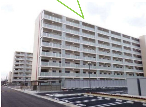
▲2・3号棟(平成28年3月)
