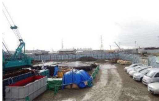
▲宮内地区:建築工事の様子(平成27年12月)
