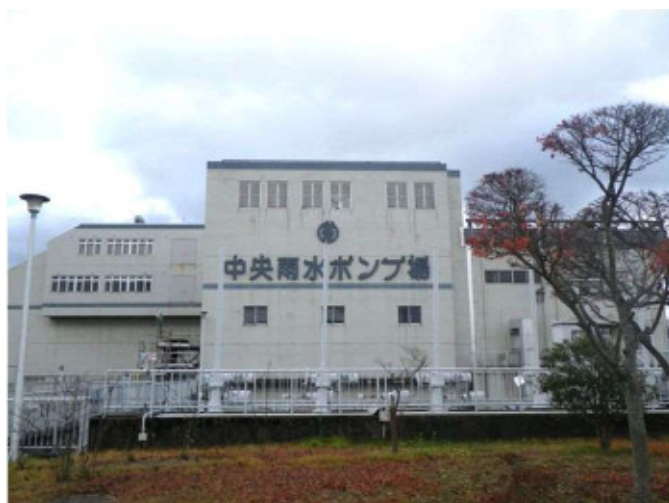
▲中央雨水ポンプ場外観の様子
