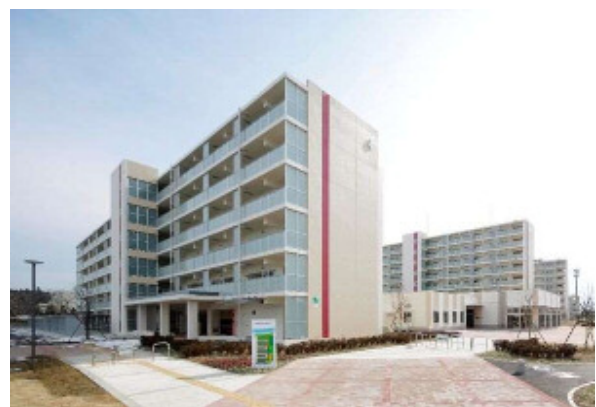
▲4号棟(平成28年3月)
