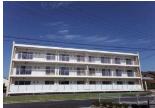
▲3号棟(平成27年9月)
