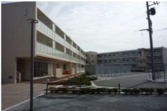
▲1・2号棟(平成27年9月)
