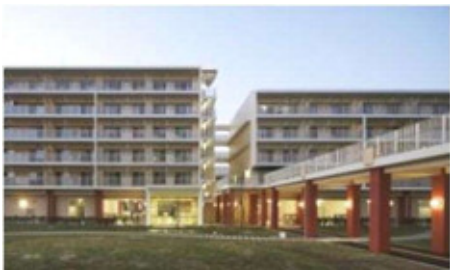
▲ 1階部分（ピロティ構造）
