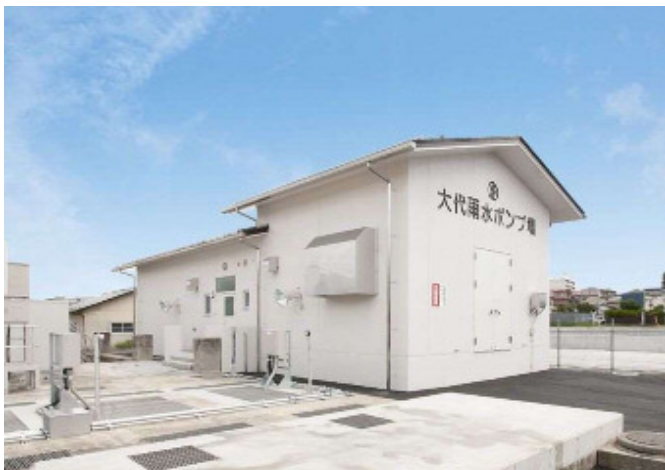
▲大代雨水ポンプ場外観の様子
