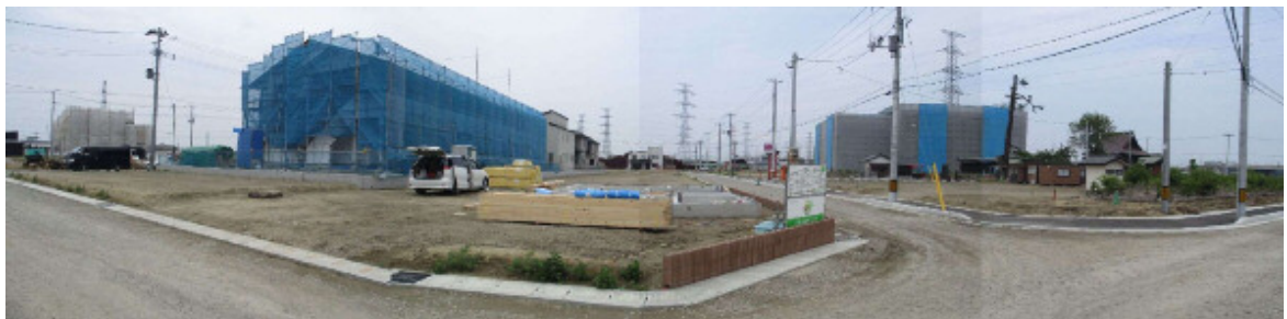
▲造成工事の様子
