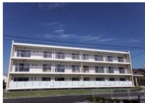
▲3号棟(平成27年9月)
