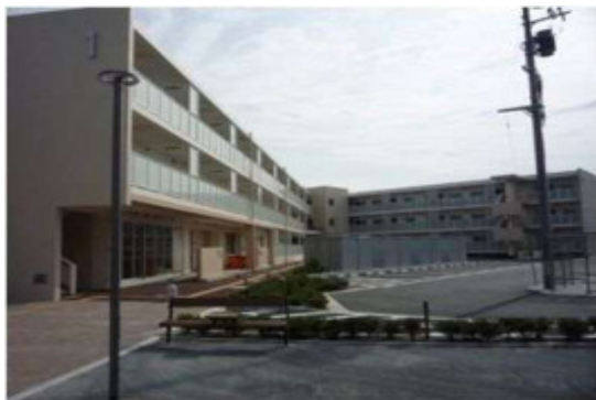
▲1・2号棟(平成27年9月)
