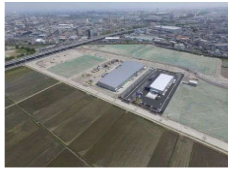
▲造成工事の様子(平成28年5月)
