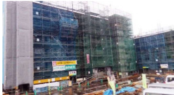
▲宮内地区:建築工事の様子(平成28年6月末)
