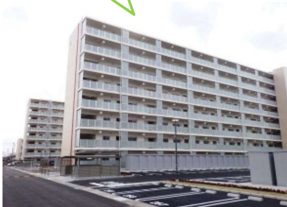
▲2・3号棟(平成28年3月)
