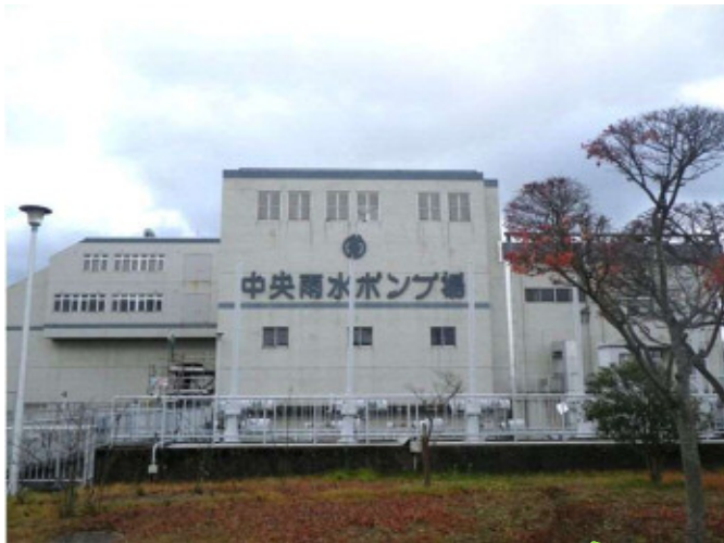
▲中央雨水ポンプ場外観の様子
