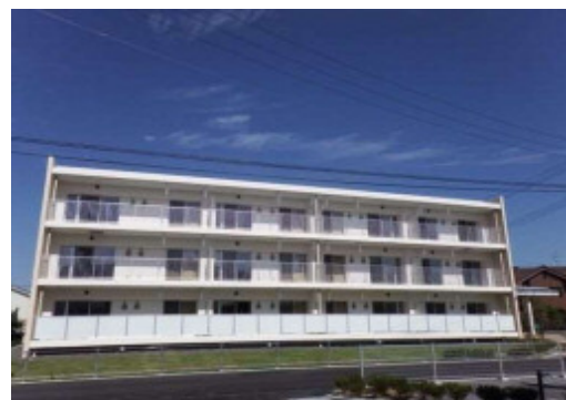
▲3号棟(平成27年9月)
