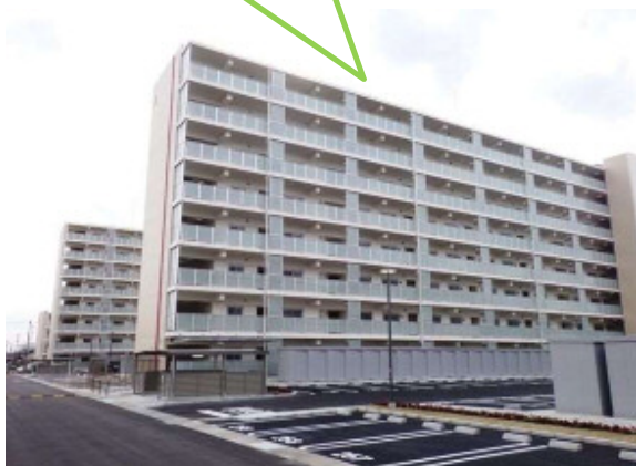
▲2・3号棟(平成28年3月)
