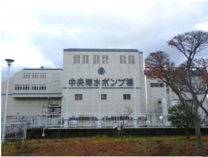
▲中央雨水ポンプ場外観の様子
