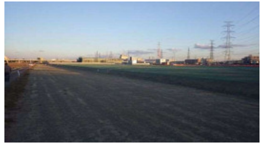
▲造成工事の様子(平成28年1月)
