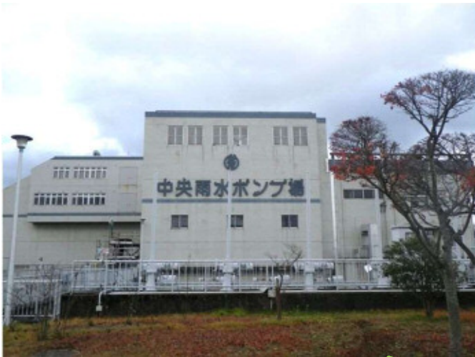
▲中央雨水ポンプ場外観の様子
