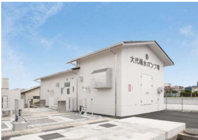
▲大代雨水ポンプ場外観の様子
