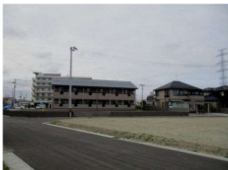
▲造成工事の様子(平成29年6月) (中心部から北方角を撮影)
