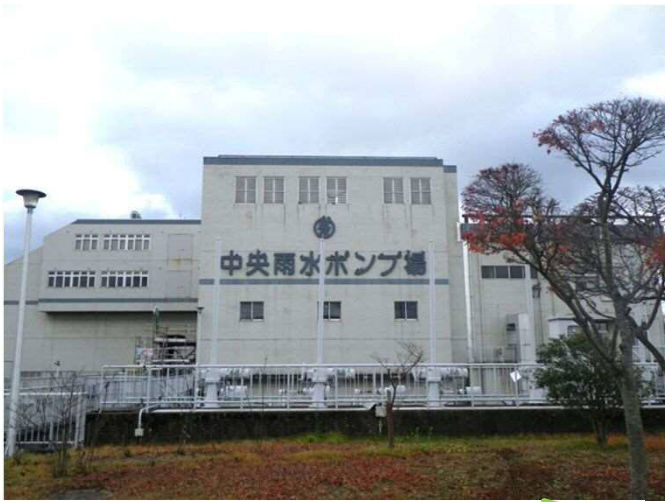
▲中央雨水ポンプ場外観の様子
