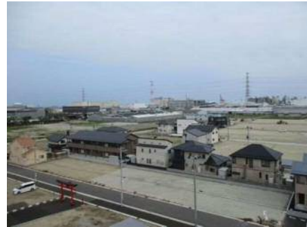
▲造成工事の様子(平成29年6月) (災害公営住宅から南東方角を撮影)
