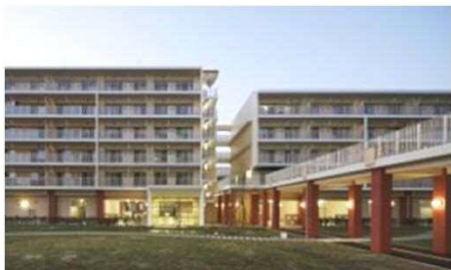
▲ 1階部分（ピロティ構造）
