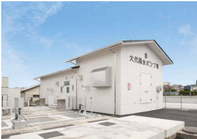
▲大代雨水ポンプ場外観の様子
