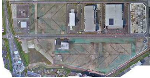
▲造成工事の様子(平成29年9月)
