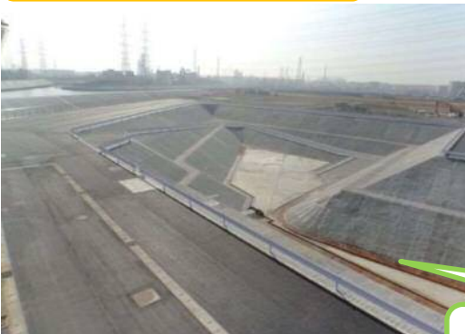
▲八幡第一雨水調整池の様子
