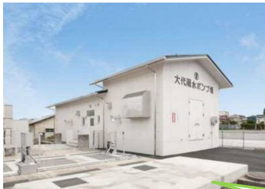
▲大代雨水ポンプ場外観の様子
