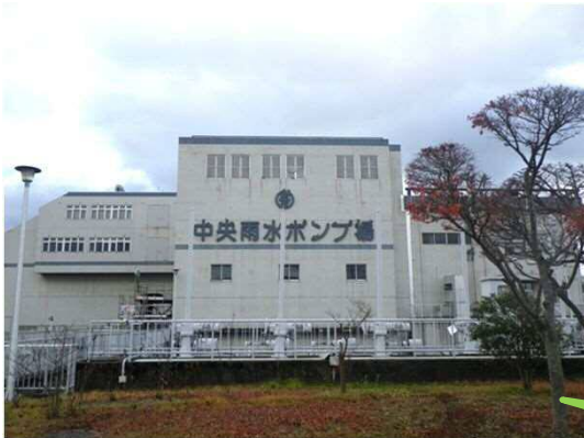
▲中央雨水ポンプ場外観の様子
