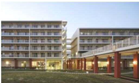
▲ 1階部分（ピロティ構造）
